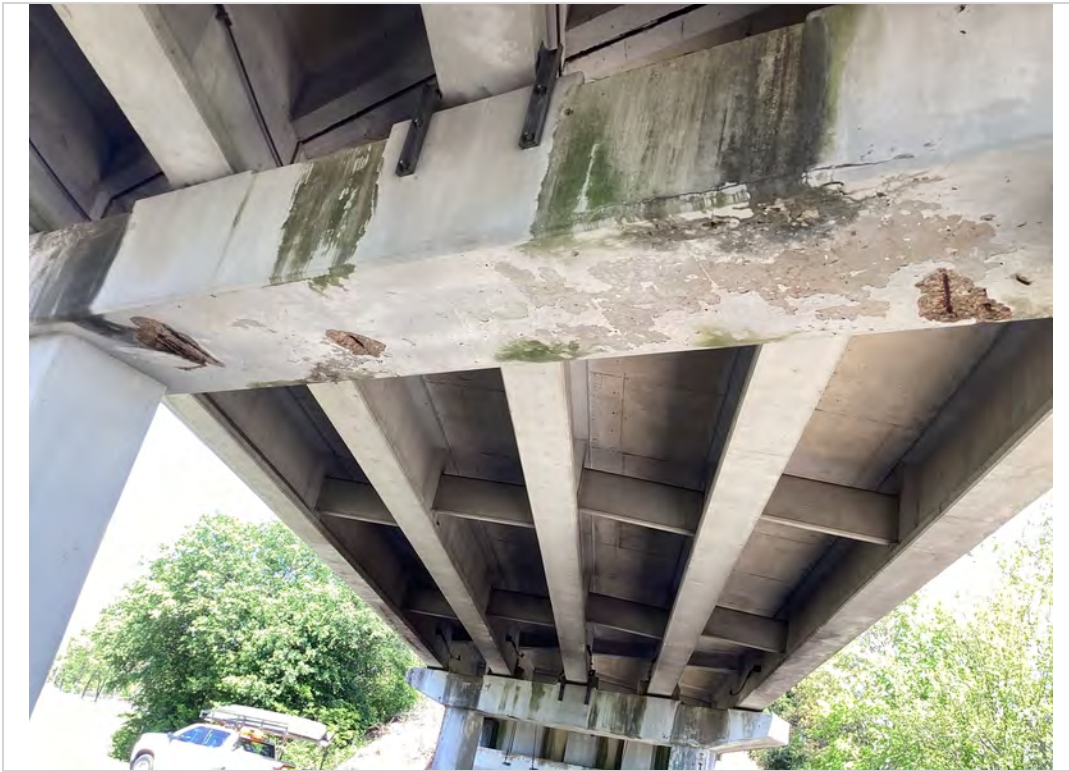
Bent 2 spall
